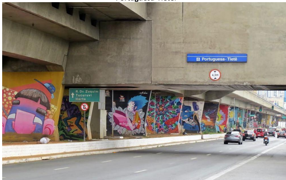
Figura 2: MAAU - Vista Geral da Avenida Cruzeiro do Sul – Zona Norte – próximo à passarela do metrô Portuguesa-Tietê.
