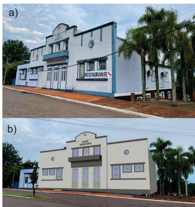
Figura 13: a) Fotografia do Clube Crissiumal atualmente; b) e modelagem 3D, conforme características originais de construção, aplicada em realidade aumentada.
