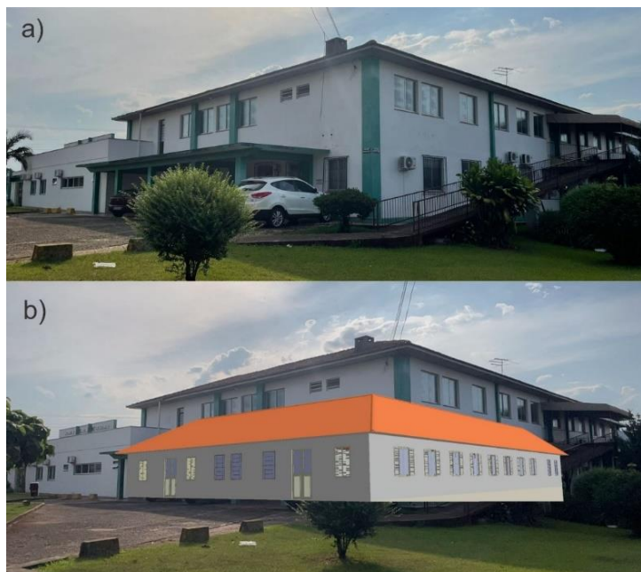
Figura 11: a) Fotografia do Hospital de Caridade de Crissiumal atualmente; b) modelagem 3D, conforme características originais de construção, aplicada em realidade aumentada.
